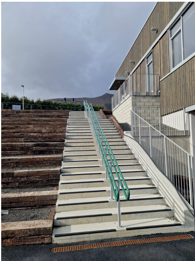
Trapp på vestsiden av bygget.
